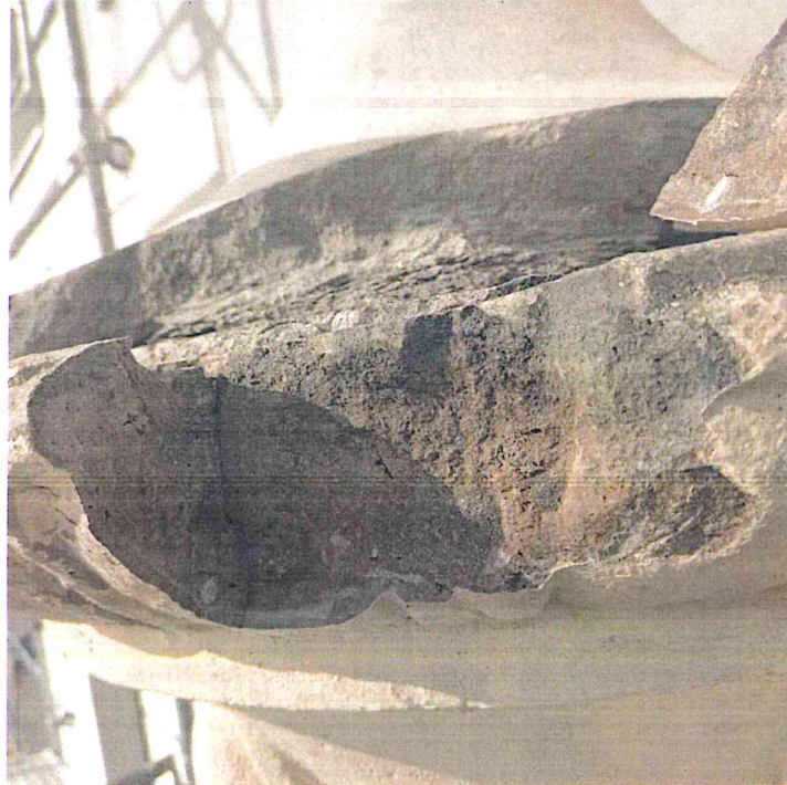
Fot. 10. Uzupełnienie cementowe korony kielicha
